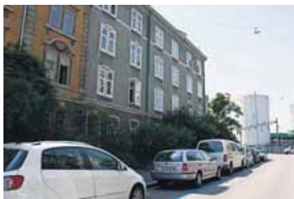
Diese Häuserzeile haben engagierte Quartierbewohner vom Abriss bewahrt.
